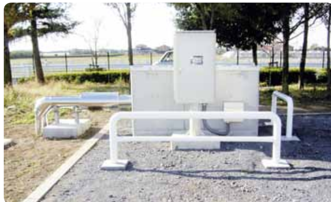
▶ 井戸完成後上部
