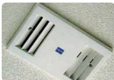
➤ 吹出口カバー取付後
