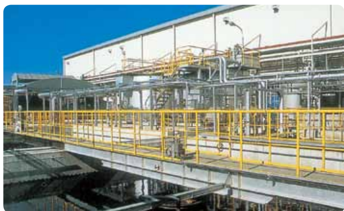
▶ 廃水処理施設
