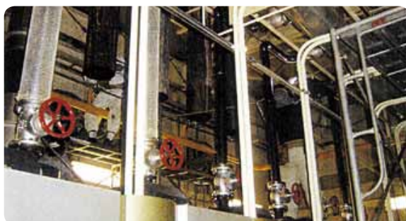
➤ ボイラー点検
